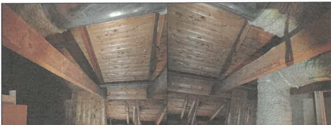
Figur 9-55 Innertak (träpanel) i trä och takstommar Innertaket är fint och utan några synliga fuktskador
