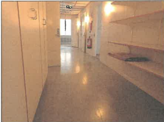
Figur 7-5 Bild visar exempel på nyare plastmatta på golv.
