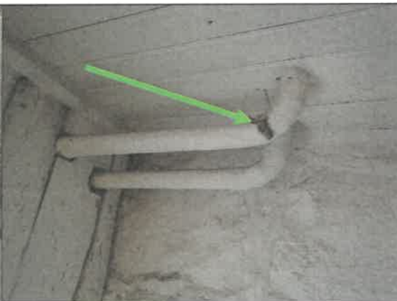
Figur 7-2 Prov 2. Gasbinda och isolering på rör. Asbest ej påvisad.
