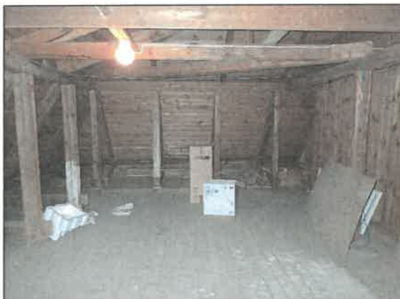
Figur 7-15 Bild visar vinden. Större delen av vinden är en kallvind men några delar är isolerade.
