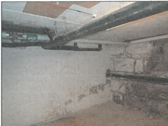
Figur 8-3 Bild visar avloppstammar som tillkommit under senare år.
