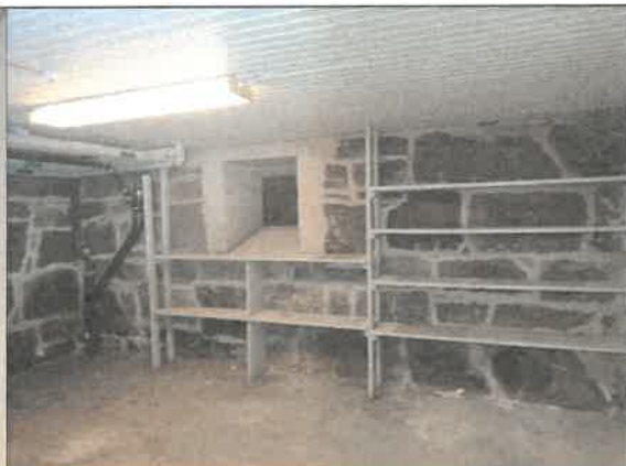
Figur 9-52 Bild visar grundmur/källare av sten.
