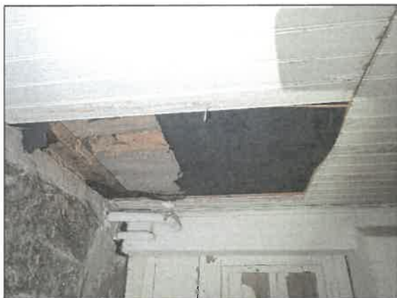
Figur 7-1 Bild visar bjälklaget med bjälklagsfyllning. Bjälklaget består av isolering av spån, plank av trä, svart tjärpapp och ytters sitter målad träpanel. Tjärpappen innehåller bitumen.
