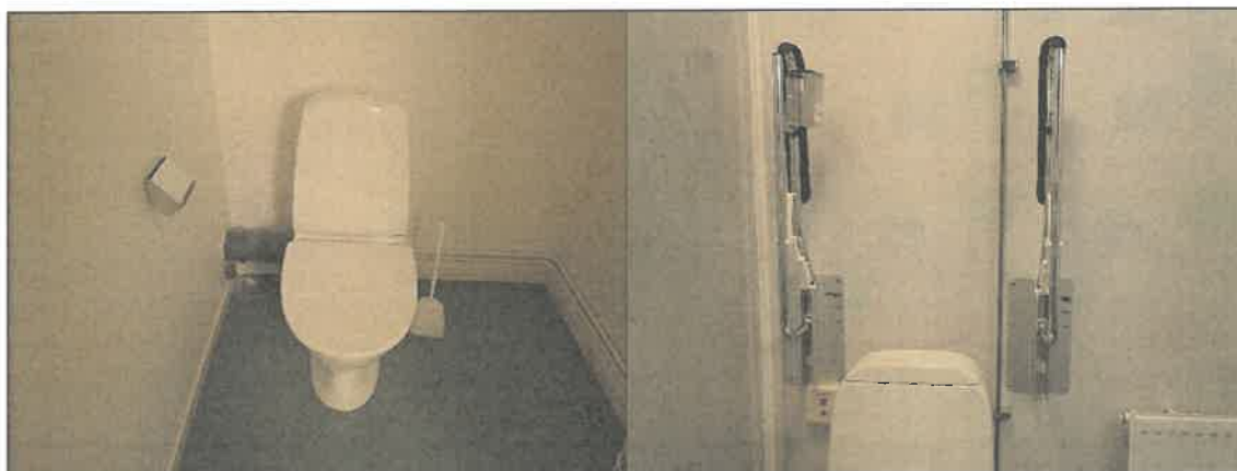
Figur 9-20 WC, golvställd, dubbel spolfunktion, 5st
