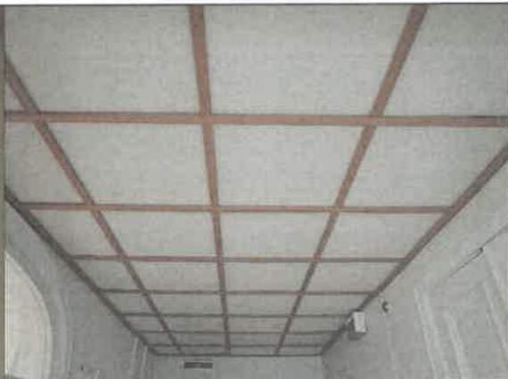
Figur 9-35 Bild visar nedpendlat innertak. Finns generellt i hela huset på enréplan och plan 2
