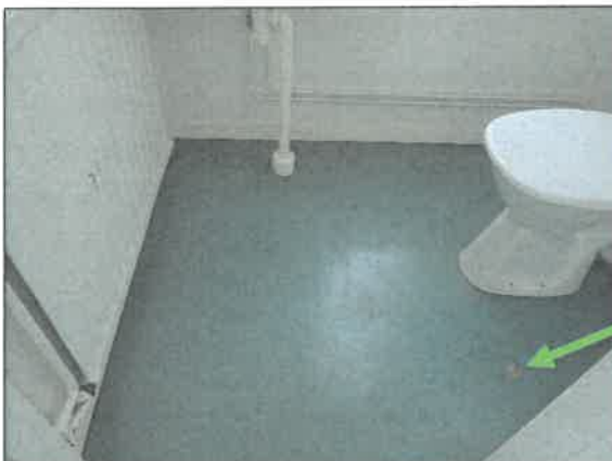
Figur 7-9 Prov 8. Avjämning/lim under blå plastmatta på WC våning 1. Asbest ej påvisad. Innehåller ej PCB över gränsvärde.
