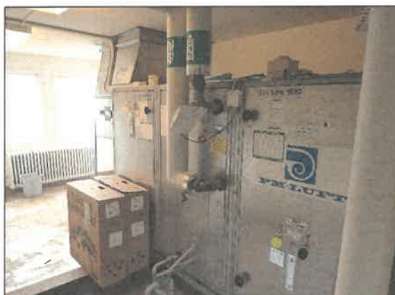
Figur 8-11 Nyare ventilationsaggregat som står på vinden.
