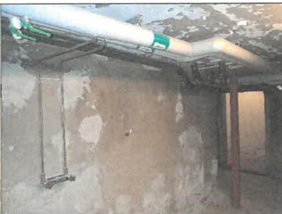
Figur 7-4 Bild visar innerväggar av tegel och puts i källare.
