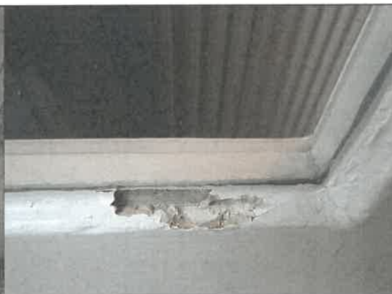
Figur 8-15 Prov 21. Fönsterkitt i dubbeldörr/balkongdörr på plan 2. Asbest ej påvisat.
