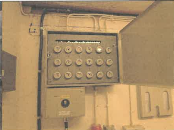
Figur 8-4 Bild visar äldre proppskåp.
