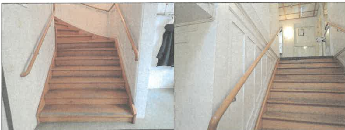
Figur 9-45 Trappa i trä med ledstång på båda sidor. Även ledstänger är av trä. Denna trappa finns vid entrén.
