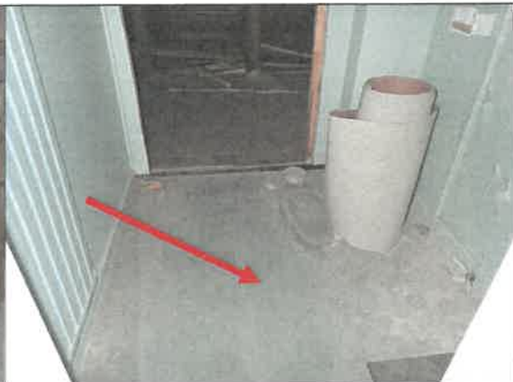
Figur 7-16 Prov 10 (analys: asbest och PCB) Grön plastmatta i rum på vind. Innehåller asbest. PCB ej över gränsvärde.
