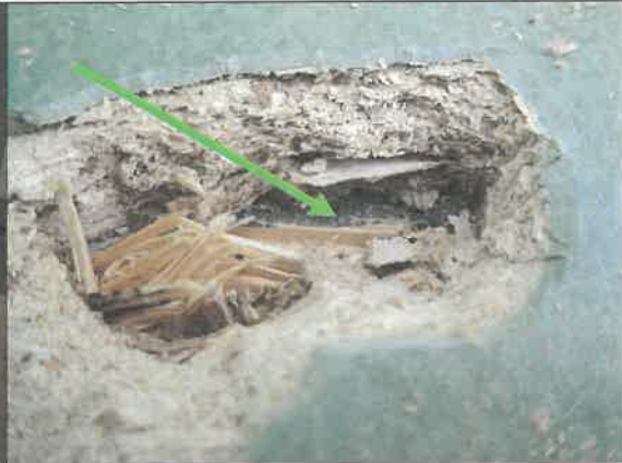
Figur 7-12 Svart under spånskiva och linoleummatta. Innehåller ej asbest.
