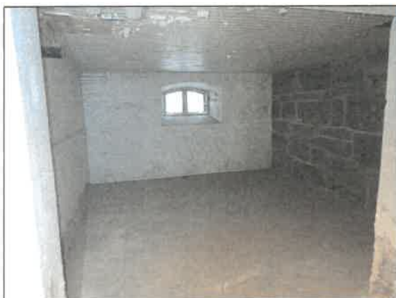
Figur 7-3 Bild visar källaren som har väggar/grund av sten och fönster i original.
