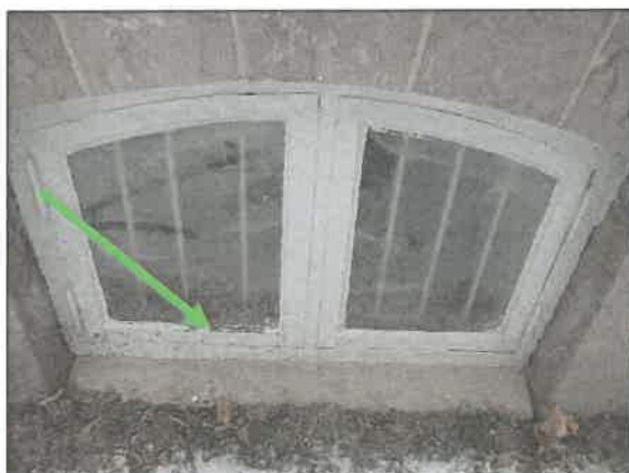
Figur 8-14 Prov 23. Kitt på källarfönster. Asbest ej påvisad
