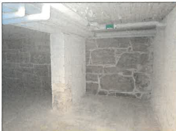
Figur 9-51 Grundmuren är byggd av sten. Dessa kan rensas från bruk för att sen återbrukas.
