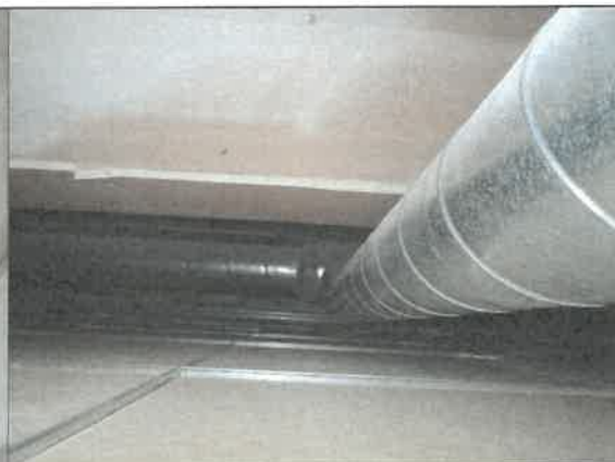
Figur 8-10 Ventilationsrör dragna i innertak. Inga äldre rör för ventilation upptäcktes under inventeringen.
