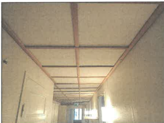
Figur 9-34 Nedpendlat innertak, mineralullsskivor med yttre bärverk av trä.
