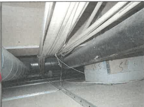
Figur 8-8 Exempel på nyare el-kablage installationer och avloppsrör i innertak.
