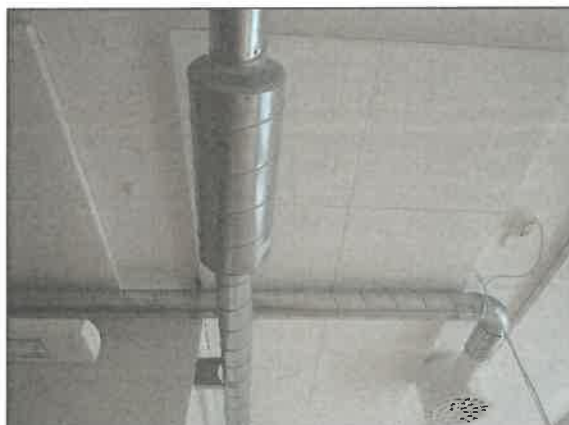
Figur 8-9 Bild visar del av det nya ventilationssystemet.
